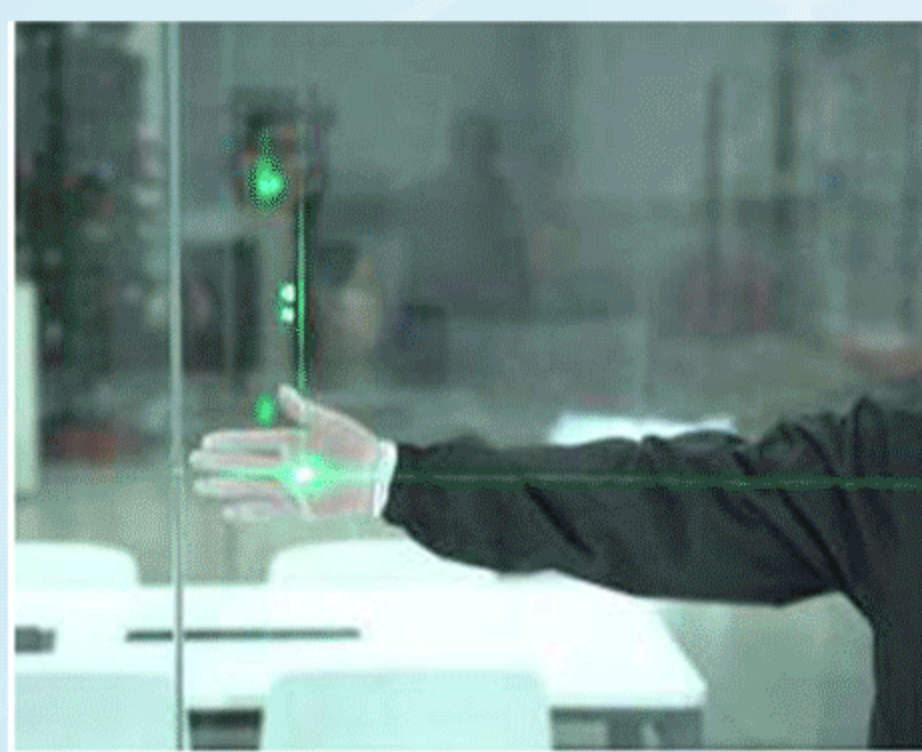
② 在组装位置处设定水平线
